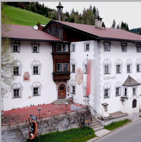
HOTEL KELLERWIRT Generalsanierung
