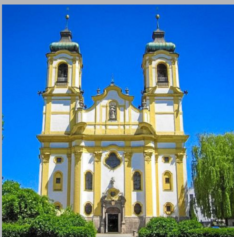
BASILIKA WILTEN Generalsanierung
