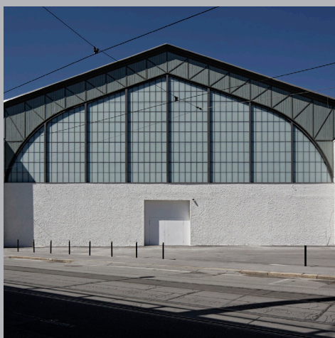
MESSE INNSBRUCK HALLE 2 Generalsanierung
