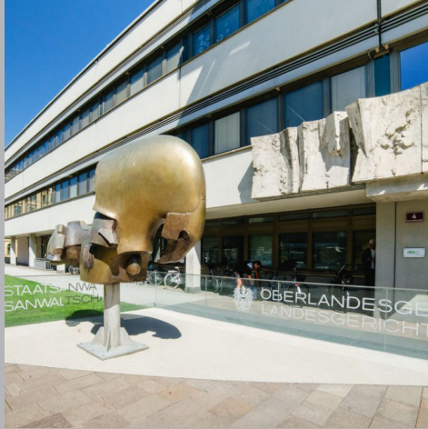
OBERLANDESGERICHT INNSBRUCK ALTBAU-BRANDSCHUTZSANIERUNG
